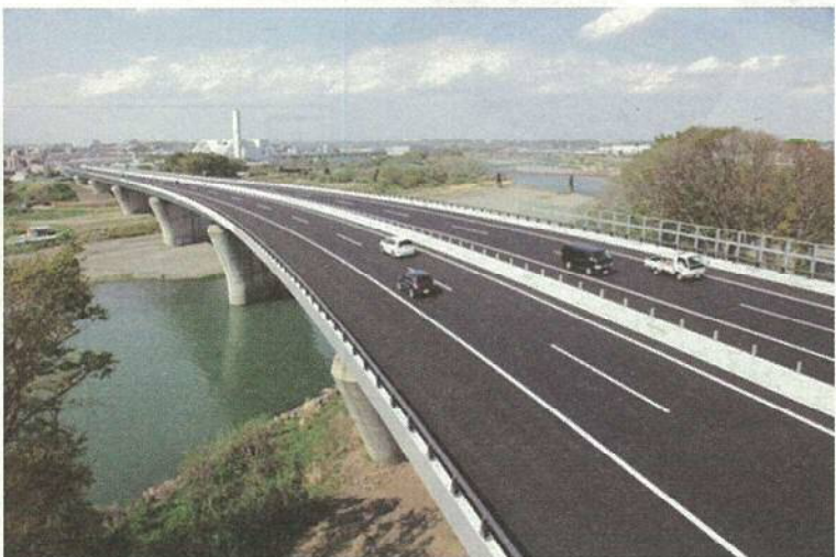
首都圏中央連絡自動車道 相模川橋
