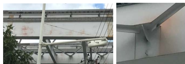
写真1 鋼軌道桁ウェブ 写真2 ガセット部
