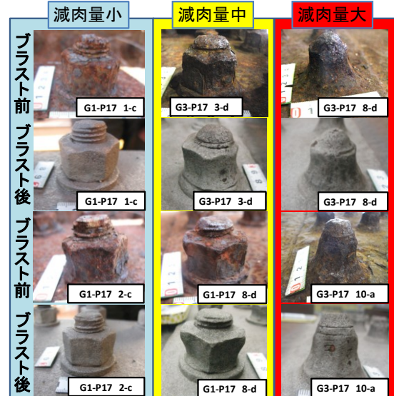
図5 外観目視による腐食劣化度分類例
