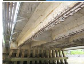
塩害により撤去されたコンクリート橋
