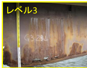
ウェブと下フランジ境界に 破断が明確に見られる場合
