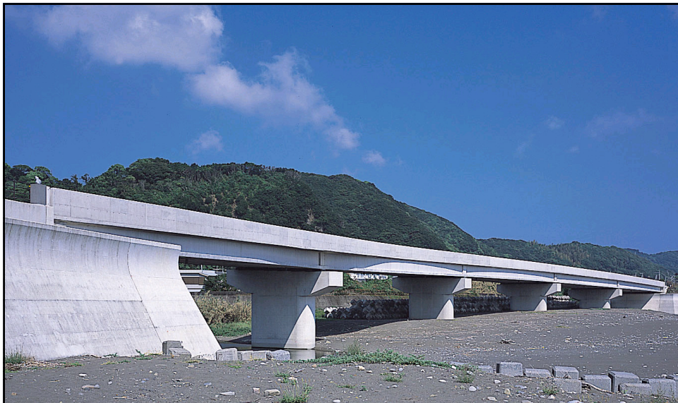
元橋（四国地方整備局） 橋長221m 5径間連続げた
