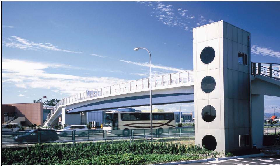
松任連絡橋（日本道路公団） 支間長60.0m 単純げた
