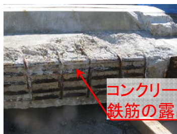
コンクリート橋
