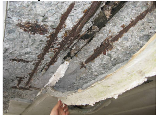
PC桁に橋軸方向クラック発生(塩害の可能性)
