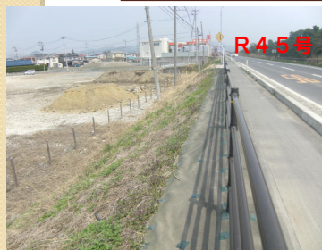
① R 4 5 石巻市付近（陸側盛土部） （浸水被害はほとんど見られない）
