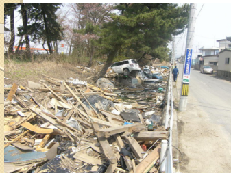
③ 石巻市 R 4 5 号海側（水路を隔てた住宅地） （水路盛土部の樹木にがれきが散乱）
