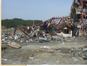
南三陸町志津川地区被災状況 (鉄骨がアメのように崩壊)
