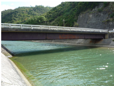
対象橋梁全景
