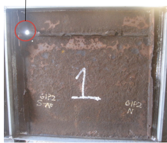
試験体4(G1桁端部)
