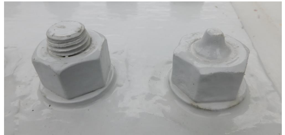
辺野喜側道路橋のボルト
