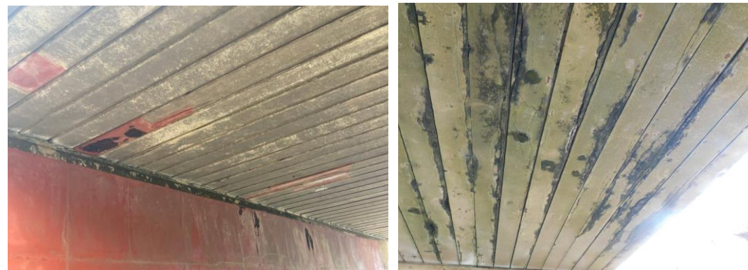
後原橋主桁部
