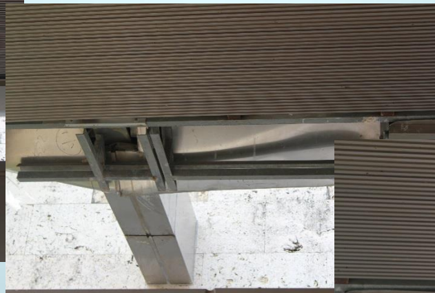
端部カバーの破損外景
