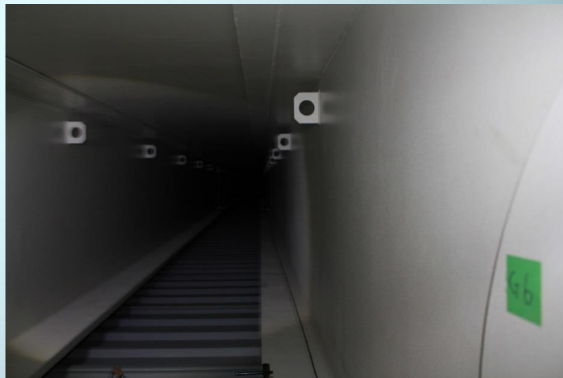
内面：損傷なし。
