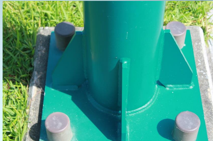
照明柱基部のリブの亀裂損傷はなかった。
