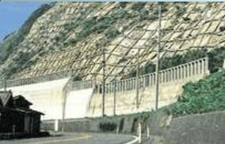
法面保護工の事例
