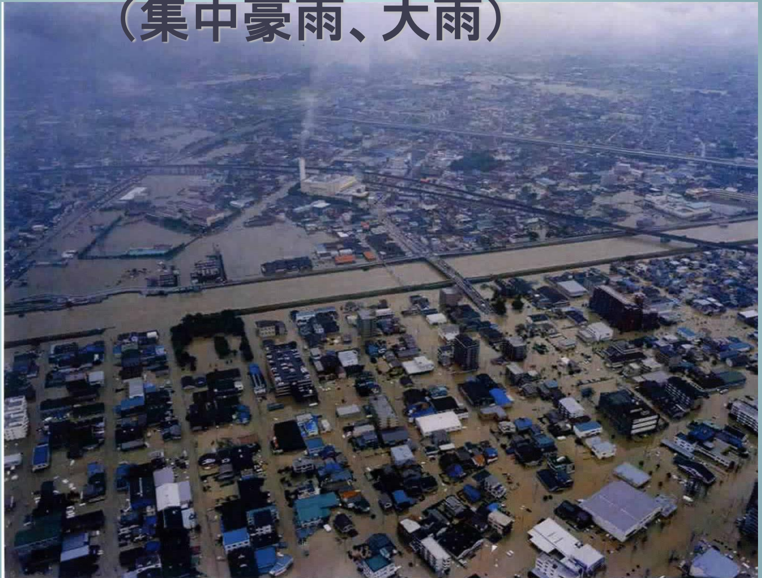
平成12年9月の「東海豪雨」により、名古屋市内を流れる「新川」の堤防が決壊し、市内が広範囲に浸水（写真提供：愛知県）
