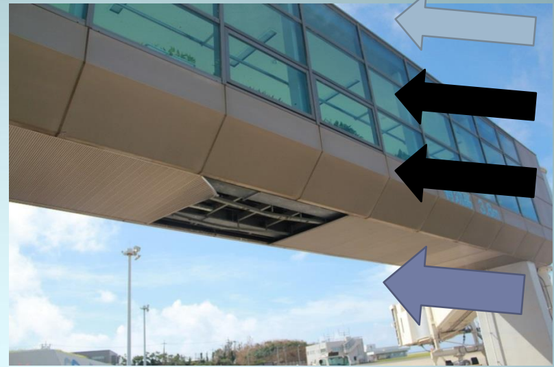
下側のカバーの破損外景
