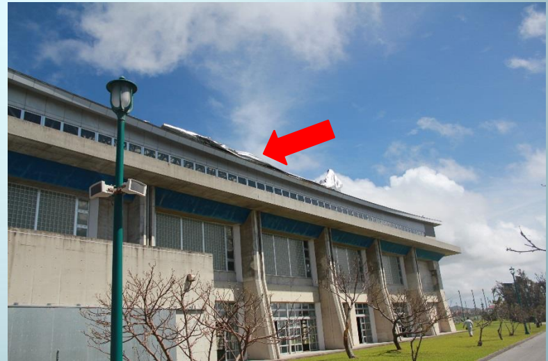
ホテルドームの屋根カバー(チタン?)が飛散し、残骸が屋根上に残っている。常風で動いているので、早期撤去が必要である。
