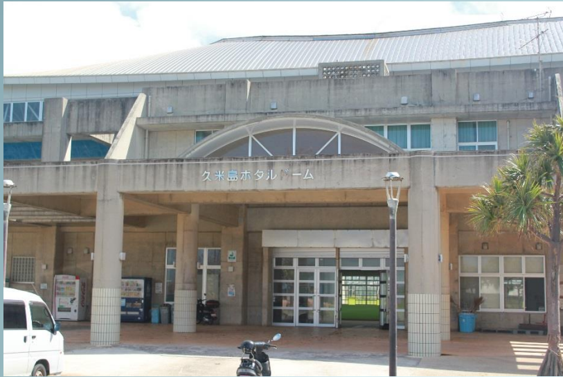
ホテルドームの入口:被害はみられない
