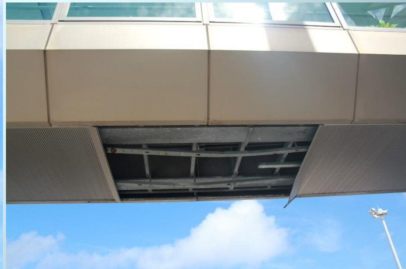
下側のカバーの破損外景
