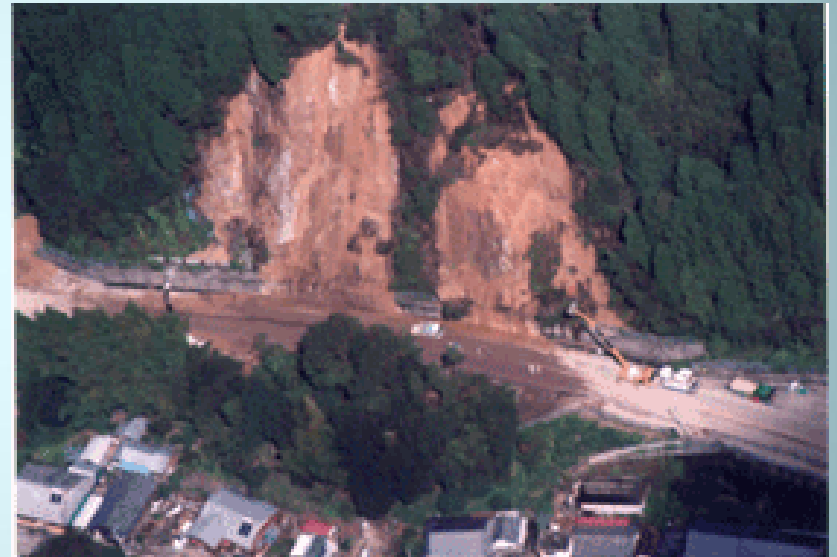
台風21号による高速道路の 大規模な土砂災害(愛媛県新居浜市付近)
