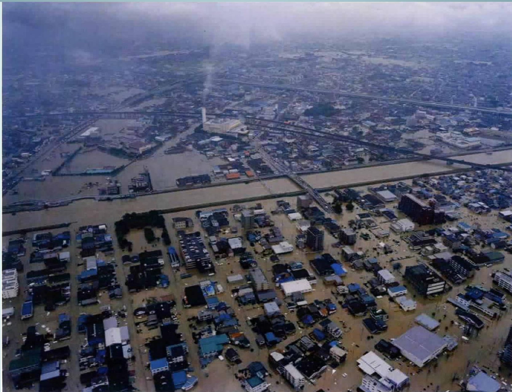
平成12年9月の「東海豪雨」により、名古屋市内を流れる「新川」の堤防が決壊し、市内が広範囲に浸水（写真提供：愛知県）
