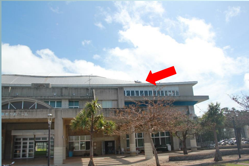
ホテルドームの屋根カバー(チタン?)が飛散し、残骸が屋根上に残っている。常風で動いているので、早期撤去が必要である。
