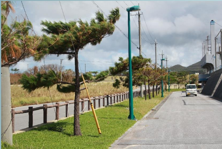
照明柱の損傷はなかった。
