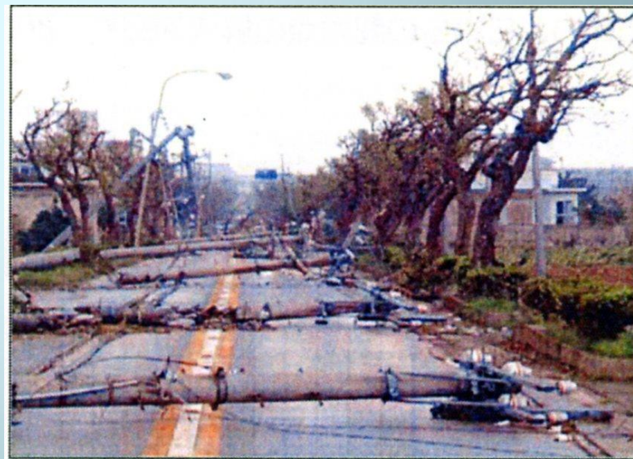
【H15.9 宮古島(台風14号被害)】
