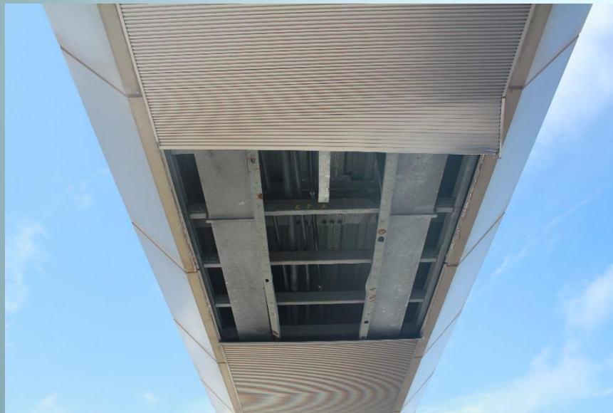
下側のカバーの破損外景
