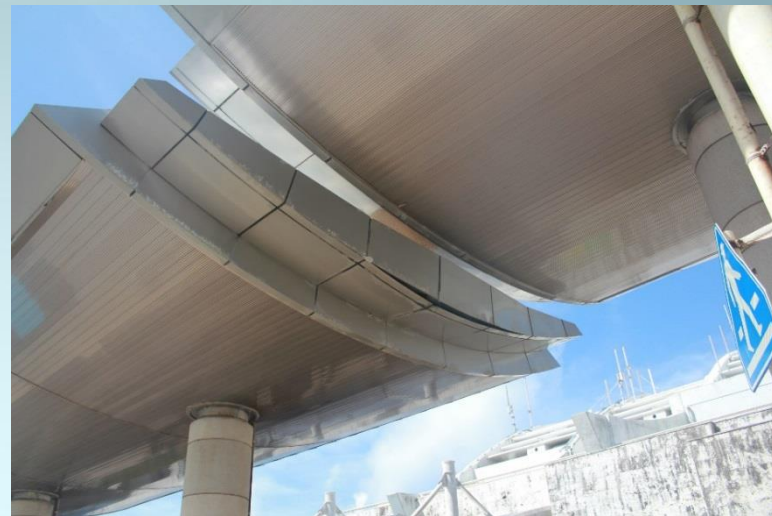
端部カバーの破損外景
