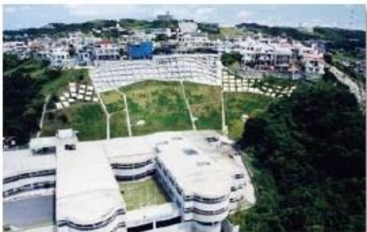
大規模な地滑りの復旧が実施された法面(南風原町)
