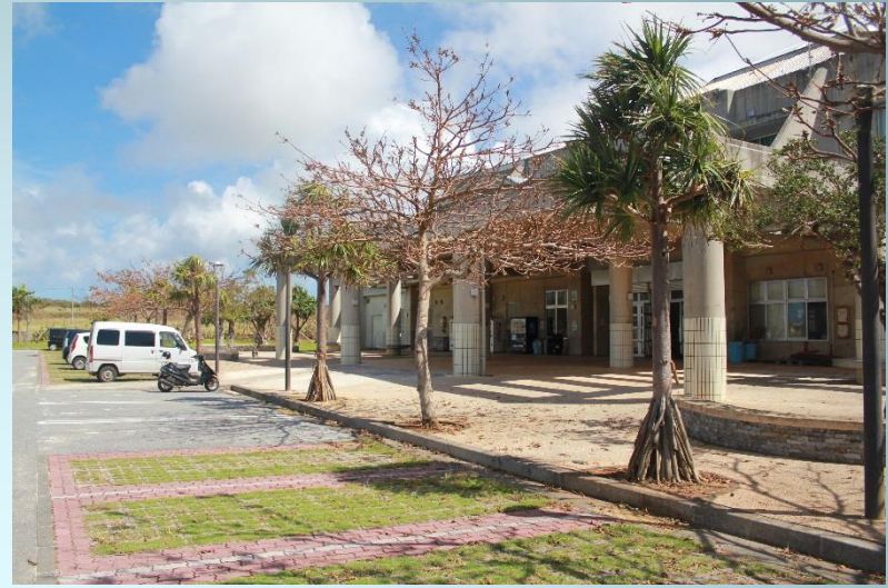
ホテルドームの入口の樹木の被害はみられない
