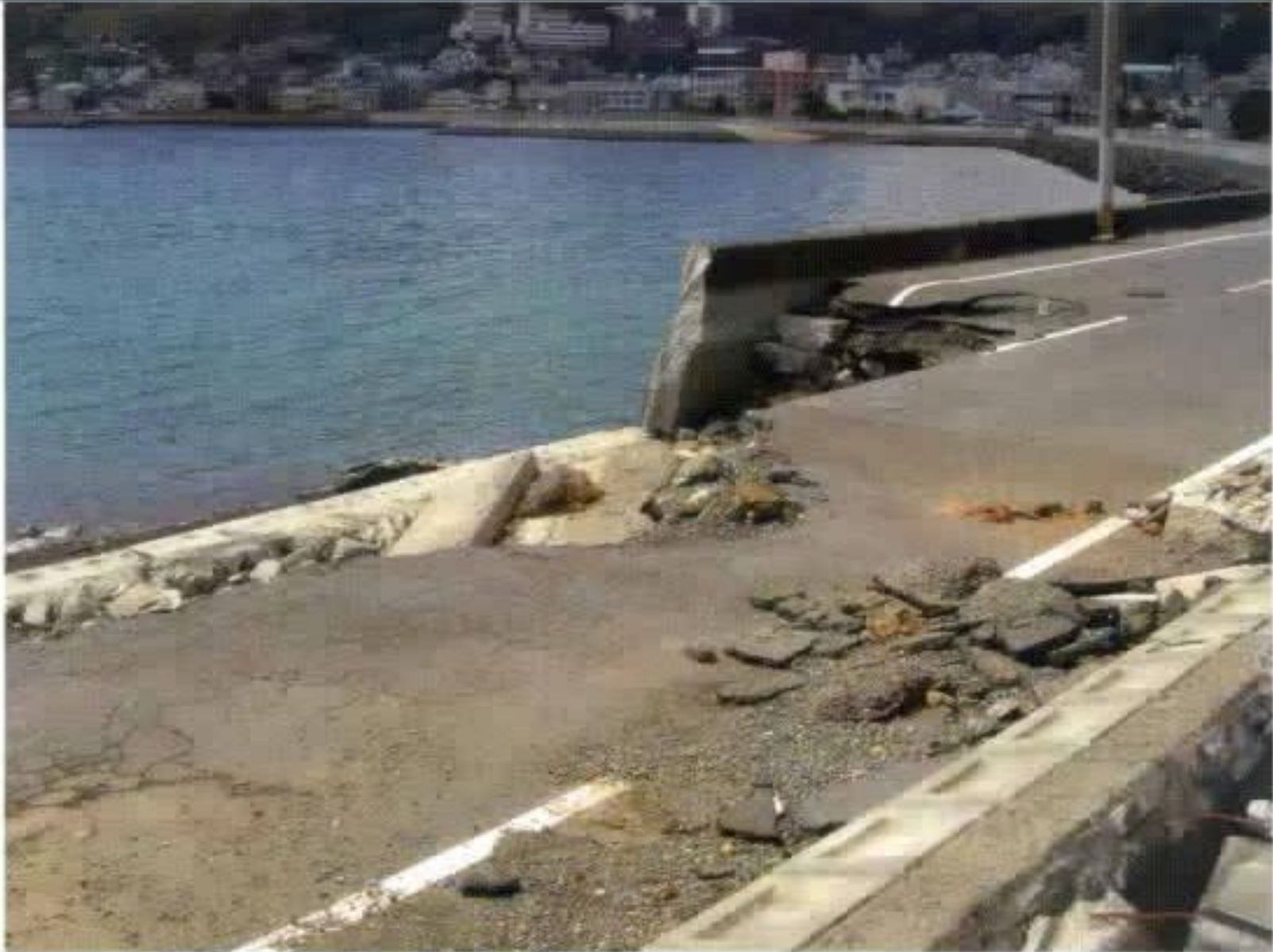
平成18年台風第13号による高波により破損した護岸 (長崎市田中町)
