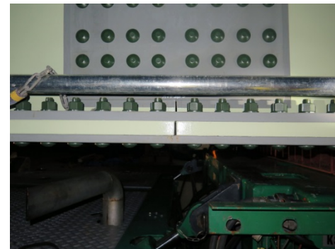
主桁のボルト継手
