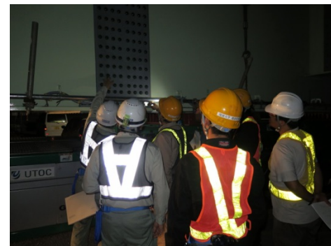
ボルトの確認
