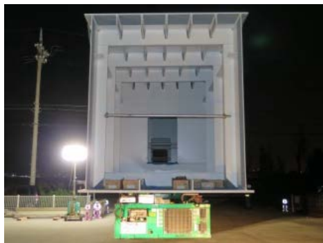
主桁の内部構造
