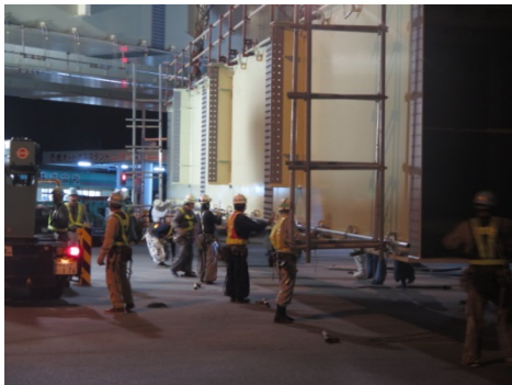
現場作業風景
