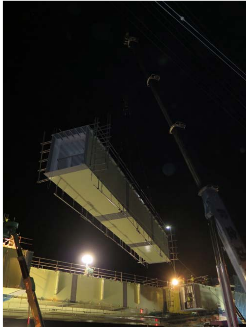
人力で主桁を微調整
