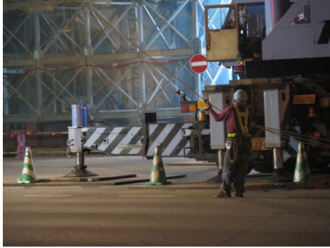
人力で主桁を微調整
